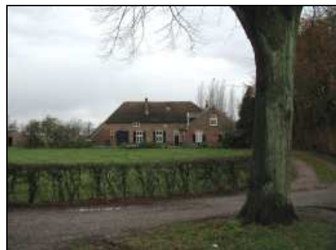
In het historisch dijkdorp staat vooral historische bebouwing. In het algemeen opgetrokken in bruine of rode baksteen en met donkere pannen of riet.
