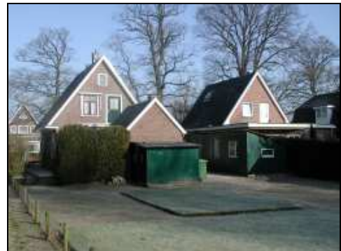
Bijgebouwen staan achter het hoofdgebouw.
