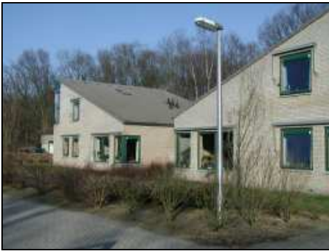
Op het terrein staan ook verschillende vormen van zelfstandig of begeleid wonen, zoals in deze nieuwbouw.
