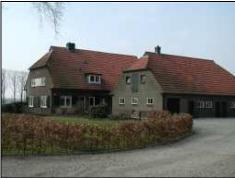
Samenhangend bebouwingscomplex met ondergeschikte bedrijfsbebouwing en een goede afstemming in kleur- en materiaalgebruik.
