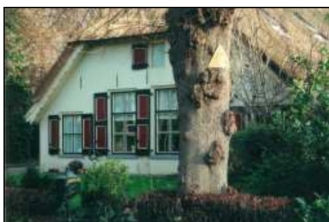
Historische hallenhuiskoerterij in Terwolde. Duidelijk waarneembaar zijn de grote gevelopeningen op de begane grond en de karakteristieke luiken en windveren.
