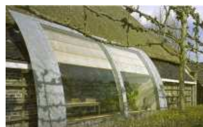
Functieverandering: de boerderij is in gebruik genomen als woonhuis met kantoor. Op een moderne, maar passende wijze, is gezorgd voor meer lichtintreding in het oorspronkelijke bedrijfs gedeelte.
