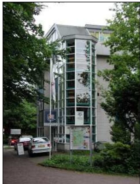
Kantoorbebouwing op het bij het vliegveld gelegen bedrijventerrein.
