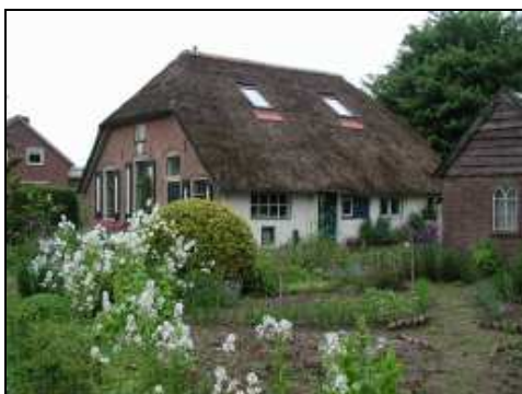
Bebouwing heeft een rechthoekige hoofdvorm. Verschillen in kleur- en materiaalgebruik geven de belangrijkheid van de gevel aan.
