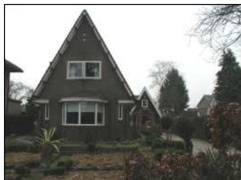
Bebouwing is voorzien en kleur- en materiaalgebruik van aan- en uitbouwen is gerelateerd aan het hoofdgebouw.
