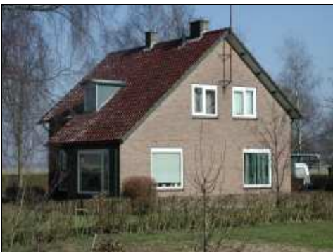
Maat en schaal van de woning passen goed binnen het dorpslint. Bij dergelijke kleinschalige bebouwing is een nokrichting haaks op de weg echter meer karakteristiek.
