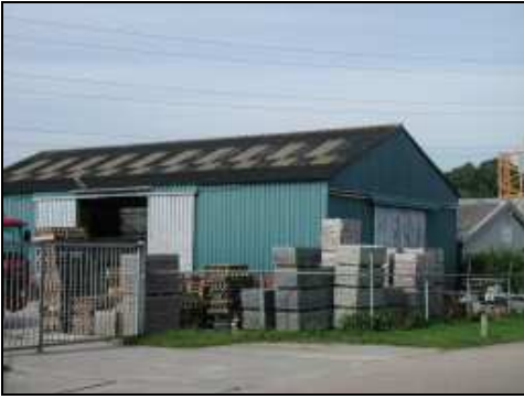
Geen bebouwing zonder gemetselde plint of met golfplaten, zoals deze loods.
