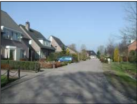
Profiel van het westelijke deel van de Dijkhuizenweg. Hier is sprake van een grotere bebouwingsvariatie en van enige bebouwing binnen de "ring".
