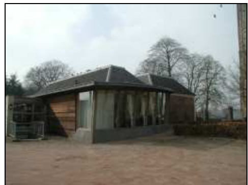
Nieuwe aanbouw van het dorps huis/bibliotheek.
