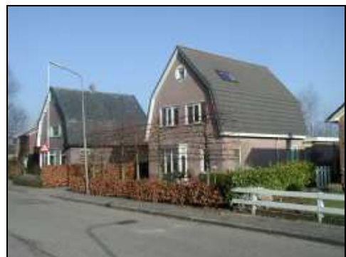
Naast vooral bijzondere bebouwing en boerderijen, komen er ook enkele woonhuizen voor. Deze nieuwbouw sluit naadloos aan bij de parcellering in het gebied en het gebruikelijke kleur- en materiaalgebruik.
