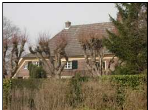
Bestaande ornamentiek en specifieke details zijn uitgangspunt bij verbouwingen.
