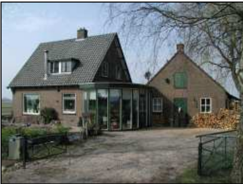
Slecht in bouwmassa, vormgeving en detaillering aansluitende serre bij het hoofdgebouw.
