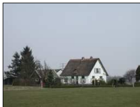
Karakteristieke burgerwoning in het buitengebied. In dit geval is gebruik gemaakt van wit pleisterwerk. Het gebruik van riet als dakbedekking is niet karakteristiek voor het buitengebied, maar misstaat niet. De dakkapel is ingetogen ontworpen.
