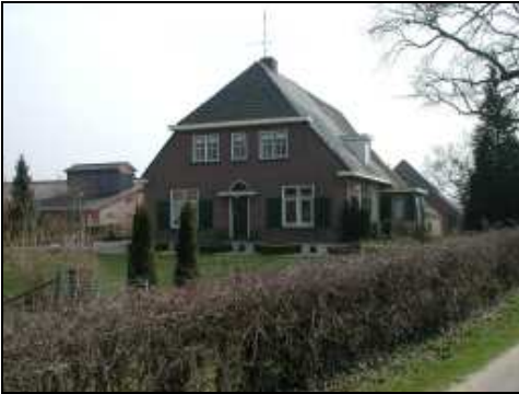
Hiërarchische opbouw van de gevel met grote vensters op de begane grond en lagere en kleinere vensters op de verdieping.
