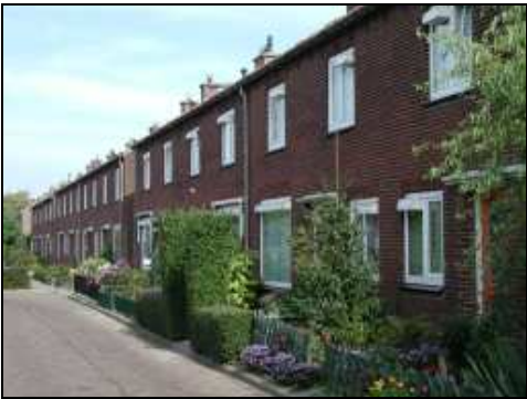
Lange gevelwanden in de Oranjebuurt.
