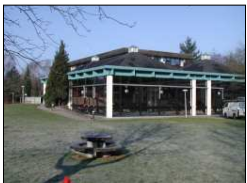
Gezamenlijke ruimte zijn open en licht door de grote glazen gevels.
