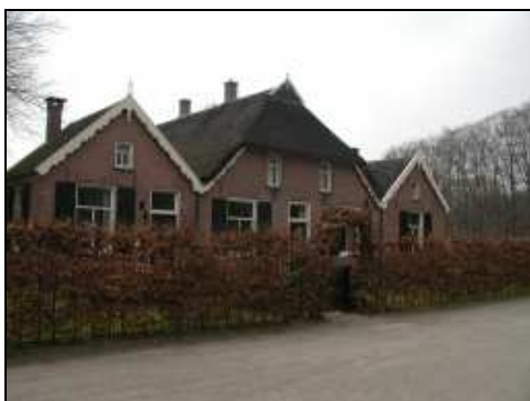
De bestaande detaillering vormt het uitgangspunt voor elke verandering.
